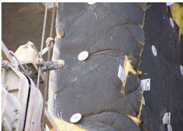
10. Неправильный монтаж утеплителя на углах фасада (п.10 табл.5)
